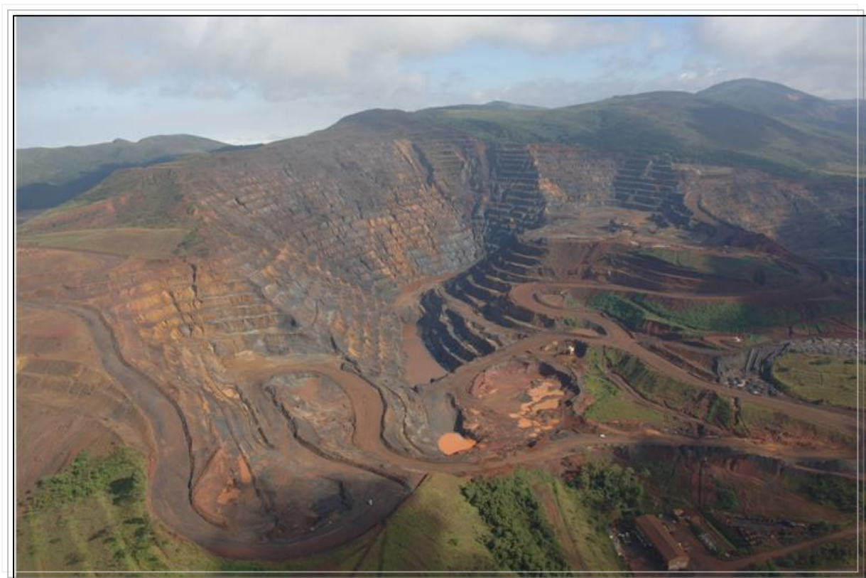
Figura 1 – Vista da Mineração Casa de Pedra.
